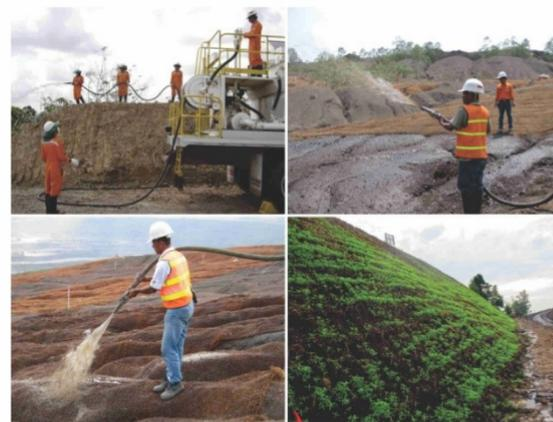
Gambar 4. metode penanaman dengan sistem *hidroseedling* dengan dikombinasikan mempergunakan cocomes (PT Unitek Borneo)
